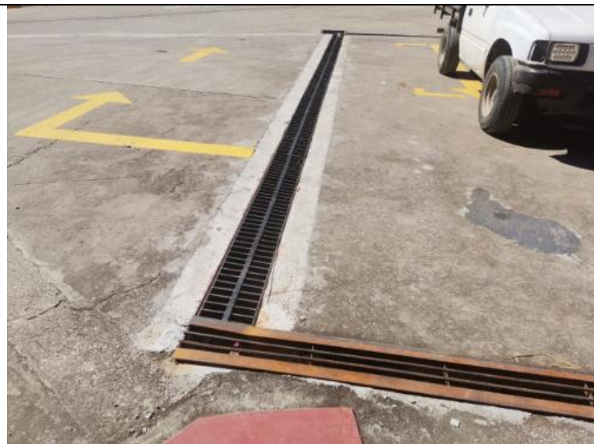
Imagen 14. Se muestra el Servicentro de Naranjo, después de hacer las reparaciones pertinentes como cajas de registro, canaletas, rejillas y pintura en general.
