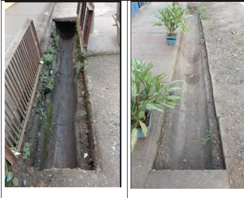
Imagen 12. Se muestra parte de la limpieza y como quedan las cunetas después de realizar la limpieza.
