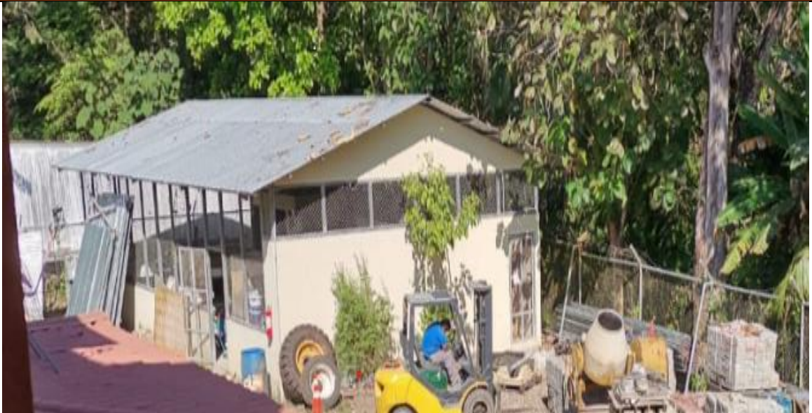
Imagen 1. Vista frontal, vista interior sector de las aulas, y se muestra el estado original del Edificio antes de su remodelación. (Obra concluida actualmente)
