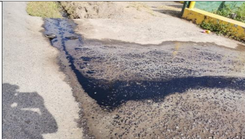
Imagen 15. Se muestra el derrame de aceite y agua que se derivó del lubricentro y cuyo destino fue hacia las cunetas frente a la calle principal.
