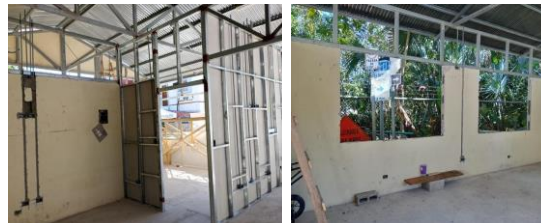
Imagen 4. Se muestra el avance físico de esta obra.
