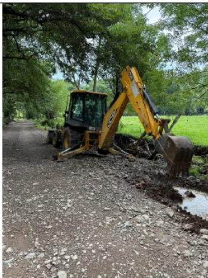
Mantenimiento en alcantarillas
