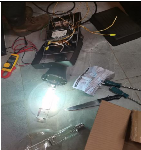
Imagen 15. Se muestra en fotografías la prueba de funcionamiento de las lámparas.
