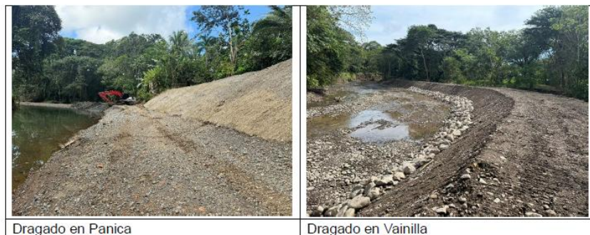
Cuadro 3. Registro fotográfico de trabajos realizados durante el 2025
